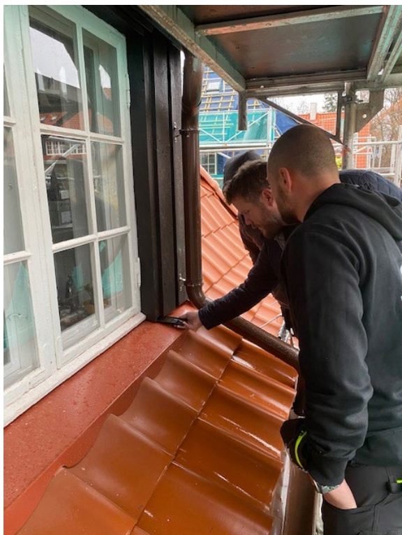
FKontrollerer at endeveden er beiset
